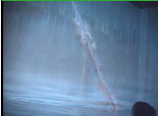
壁面亀裂上昇（気中）
