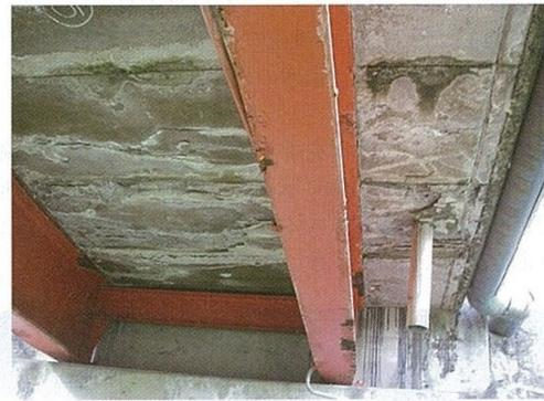
写真 - 2 コンクリートの浮き・漏水
