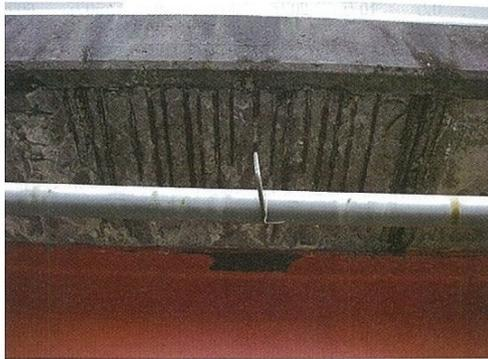
写真 - 1 コンクリートのはく離・鉄筋露出
