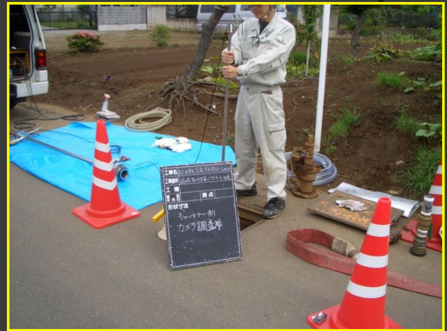
管内カメラによる止水確認
