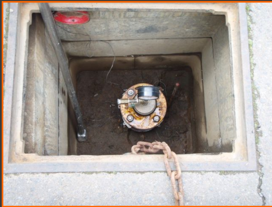
圧力計による止水確認
